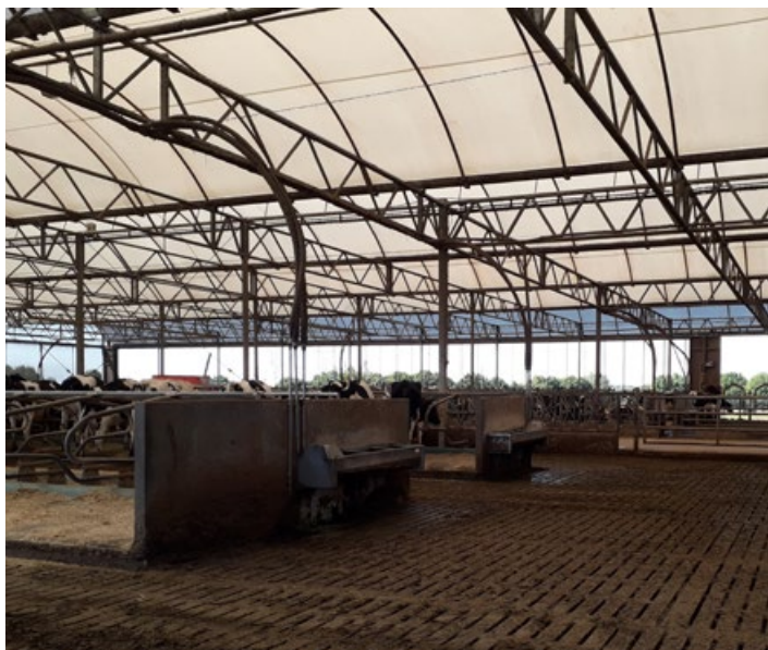
Photo 23 Un bâtiment tunnel pied droit avec une toiture non isolée
