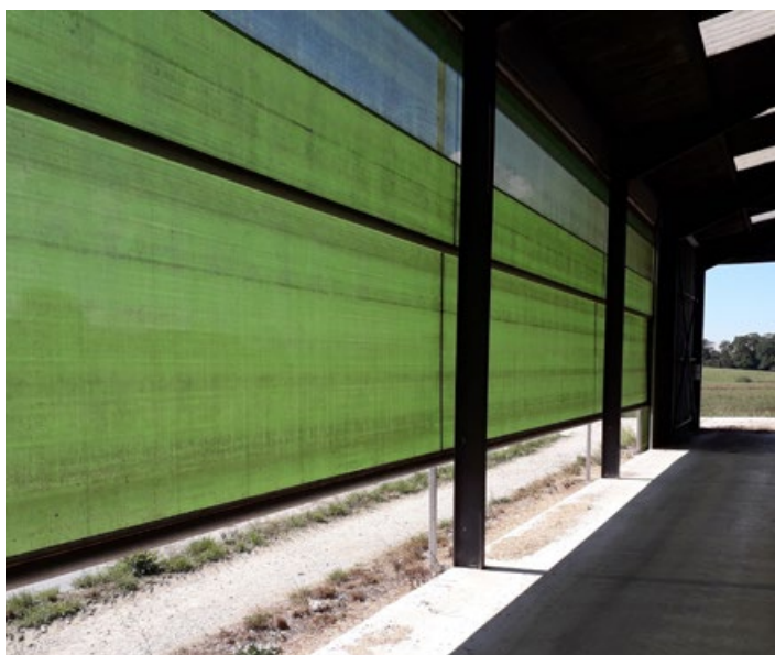
Photo 12 Rideau fermé partiellement pour limiter le rayonnement direct tout en conservant une ventilation en partie basse Crédit photo Idele
