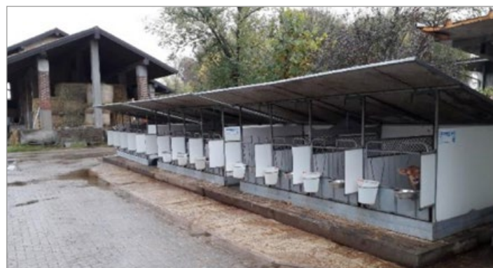
Photo 33 Des modules isolés et préfabriqués pour le logement des veaux Crédit photo Idele
