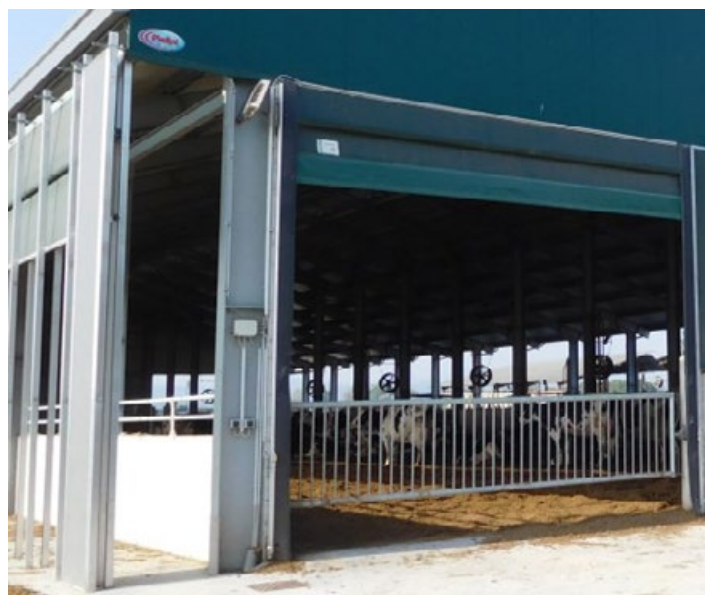
Photo 13 Rideau décalé du poteau pour assurer l'ombrage tout en facilitant la circulation de l'air Crédit photo BTPL
