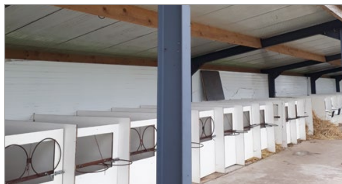
Photo 35 Une nurserie construite « en dur » ouverte et isolée en toiture et sur une façade. Une ouverture ventilante au-dessus du mur isolé est protégée par un débord de toiture Crédit photo Idele
