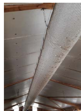
Photo 18 Ventilateur aspirant l'air extérieur pour une distribution dans une gaine de ventilation (Crédit photo : Idele)
